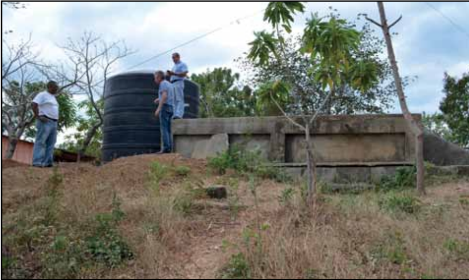
Neben dem alten Wasserbehälter in San José Km 54 wurde ein neuer Tank für 22.000 l Fassungsvermögen installiert.
