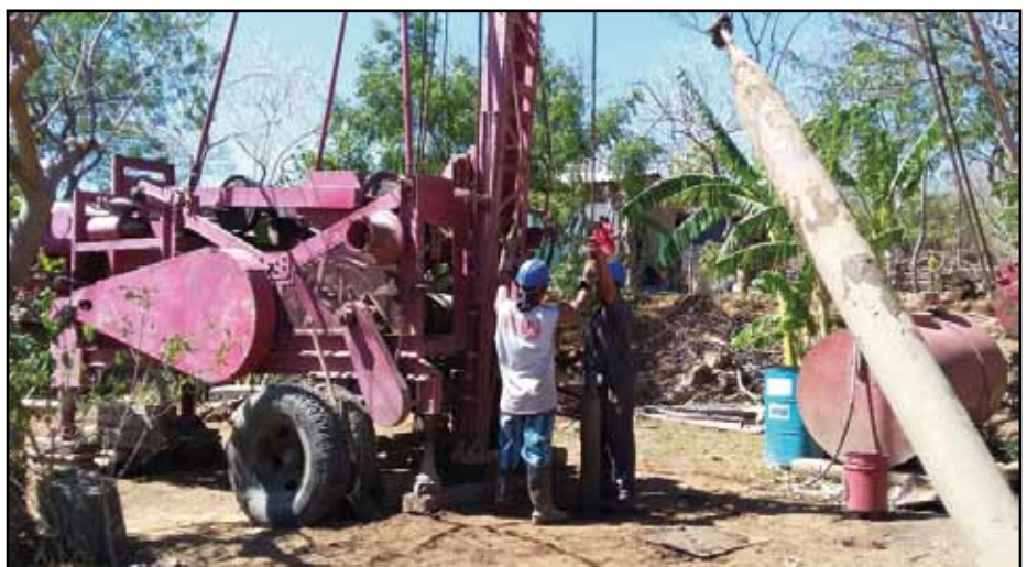
Bohrarbeiten für den neuen Brunnen in San Cristobal
