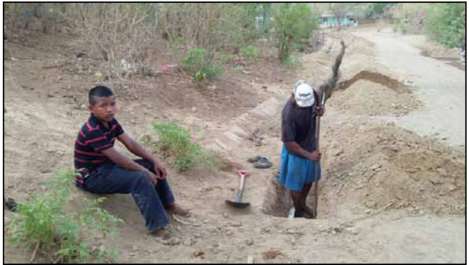
Bauarbeiten für die neuen Rohrleitungen in San Cristóbal
